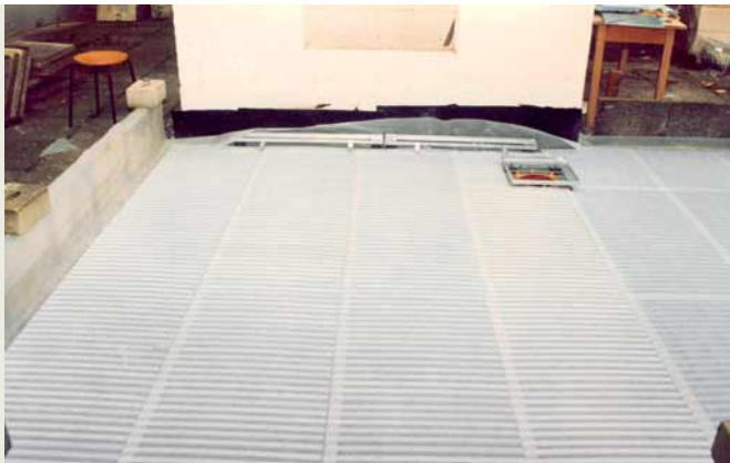
Die innere Entwässerungsebene wurde mit Drainagematten auf dem abgedichteten Gefälleestrich hergestellt und wie die äußere an den Bodenablauf angeschlossen.
