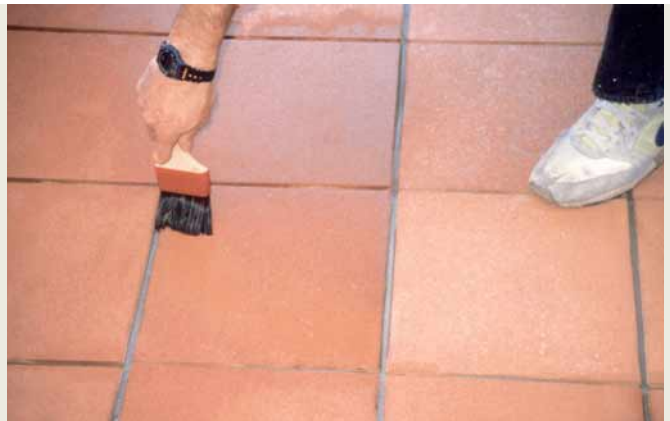
Die Cotto-Platten wurden sowohl vor als auch nach dem Verfugen imprägniert, zum einen als Schutz vor Verschmutzungen durch den Fugenmörtel, zum anderen, um das Eindringen von Feuchtigkeit in die Platten zu beschränken.
