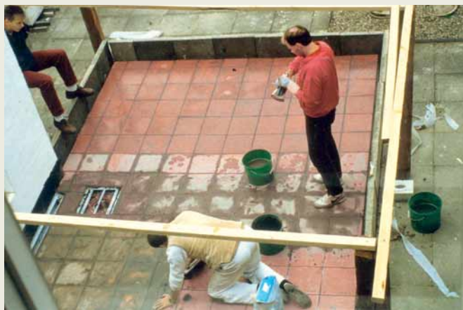
Um die äußere Entwässerung sicherzustellen, wurde auch auf die sachgerechte Ausführung der Fugen geachtet.
